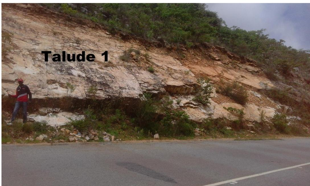
Figura 5.2 – Representação do 1º troço do Talude 1, em que se registam situações de deslizamento planar.
