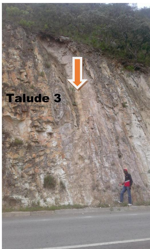
Figura 5.4 – Representação de uma rotura em cunha presente no segundo troço do Talude 3.
