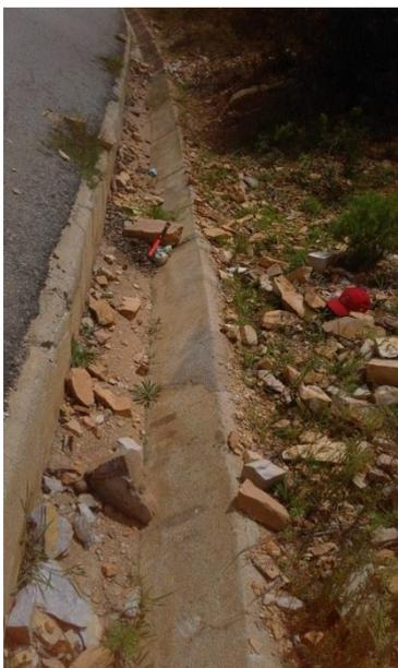
Figura 4.4 - Blocos rochosos presentes numa vala de um talude localizado na Serra da Leba.
