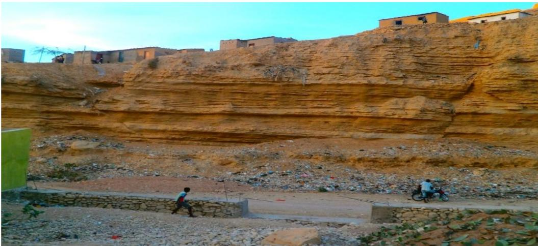
Figura 5.9 – Visualização das litologias, queda de blocos, depósitos de cobertura e algumas falhas, no Talude 8.
