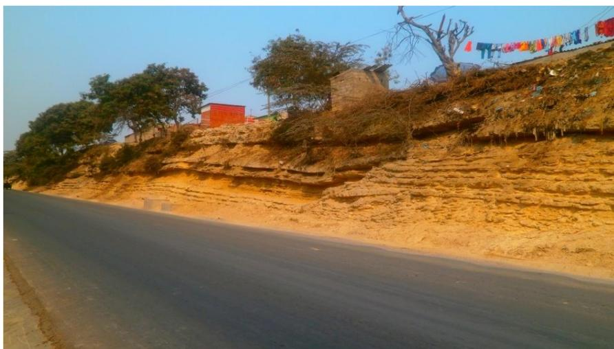
Figura 5.7 – Fotografia do Talude 6 onde se visualizam litologias, algumas falhas e fluxos.
