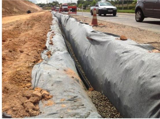
Figura 3.4 – Construção de vala drenante (Fibratex, 2014)
