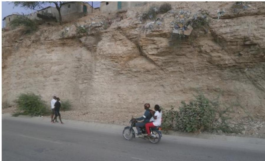
Figura 5.4 – Fotografia do Talude 2 em que se visualiza a presença de falhas e das roturas em cunha.
