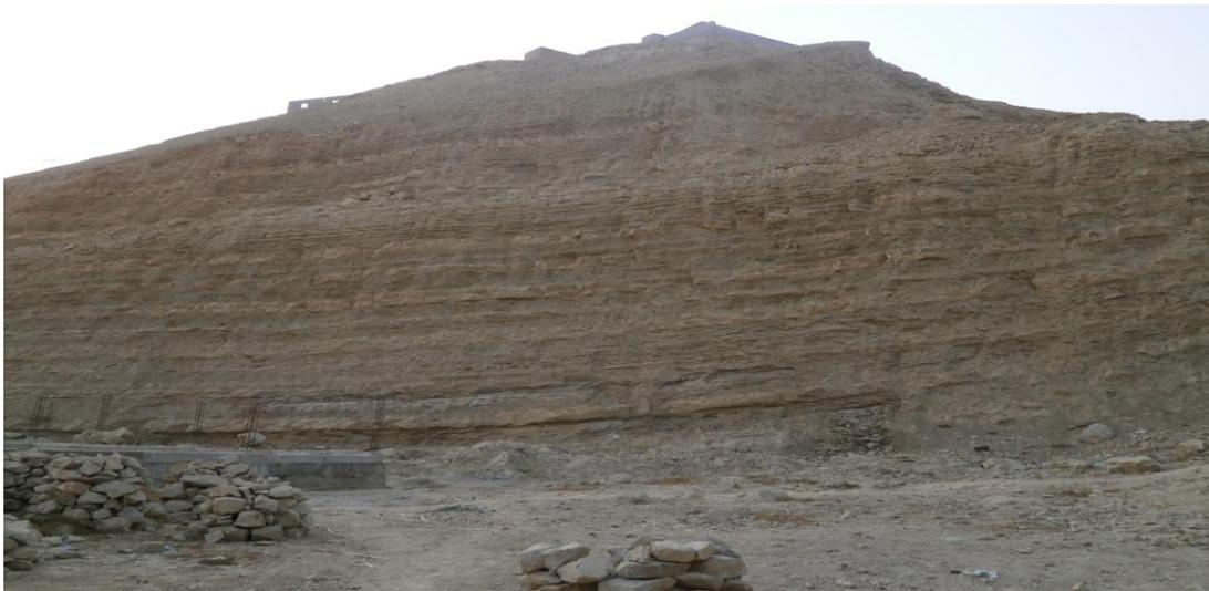
Figura 5.8 – Representação do Talude 7 onde se pode observar a alternância dos calcários e das margas e a presença da queda de blocos rochosos.
