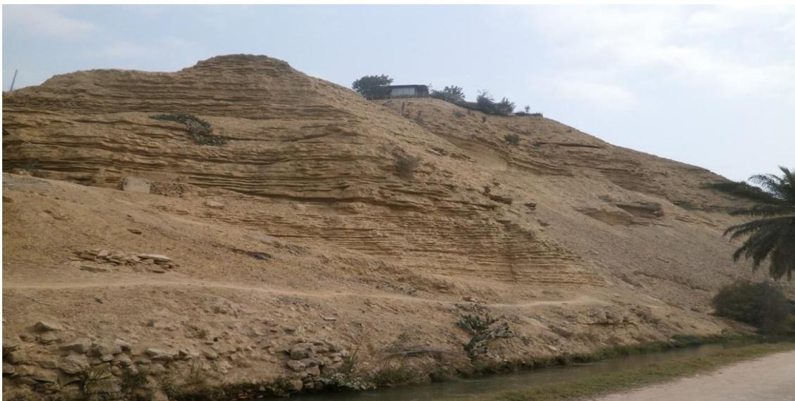
Figura 5.11 – Litologias presentes no Talude 11 e situações de instabilidade como desmoronamentos e fluxos.
