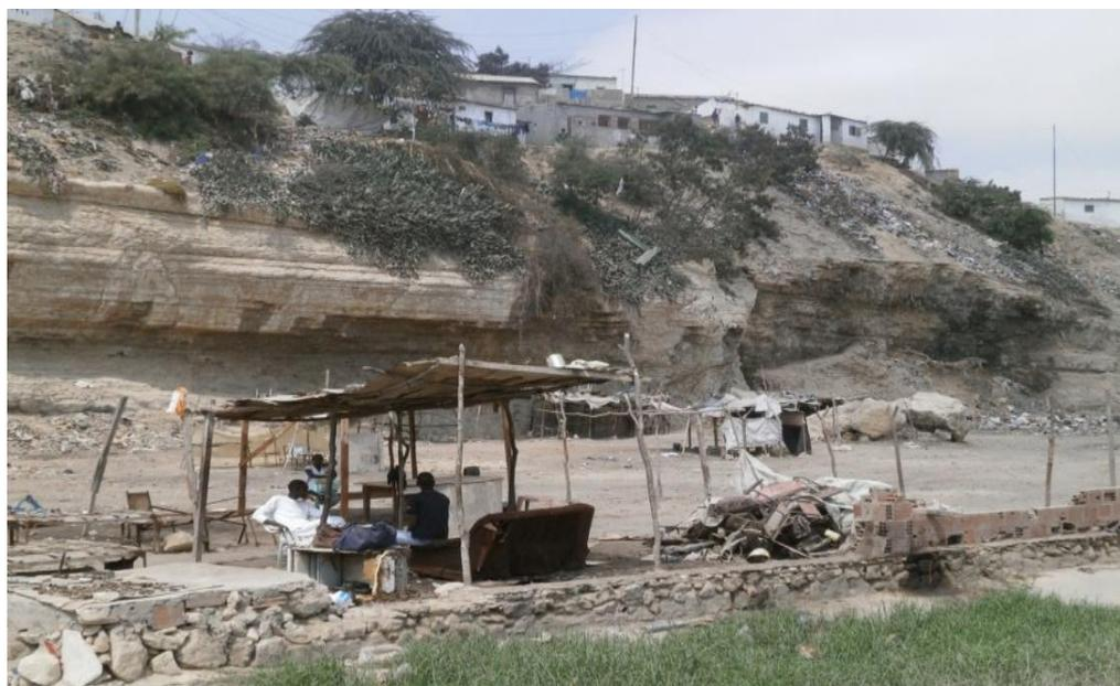
Figura 5.3 – Visualização da litologia e queda de blocos do Talude 1.
