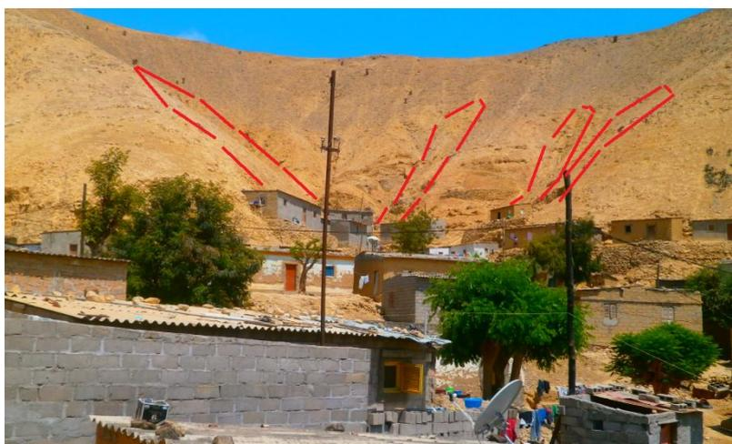
Figura 5.10 – Probabilidade de ocorrência de fluxos, assinalados a vermelho, que podem atingir várias habitações localizadas na área do Talude10.
