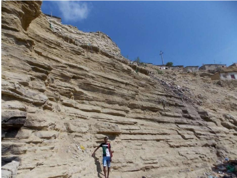
Figura 5.5 - Talude 4 (Bairro do Caputo baixo), onde se observa a alternância dos estratos de calcários e de margas, bem como se pode visualizar a erosão superficial.
