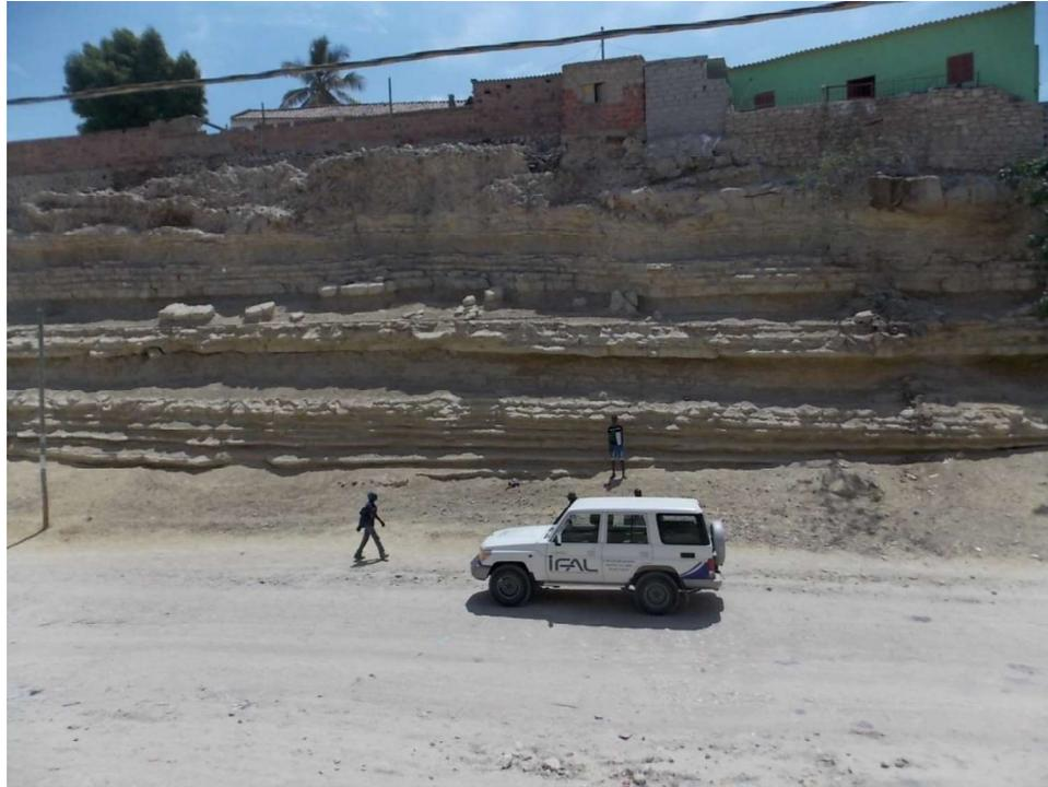
Figura 5.2- Talude 1 (Bairro do Cambambi), onde se pode observar estratificação de calcários e margas, as situações de quedas de blocos e as consequências desta instabilidade.
