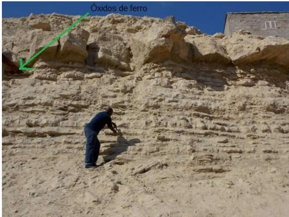
Figura 5.6 -Talude 5 (Bairro da Tata - Cal), visualização da estratificação e presença de óxidos de ferro.
