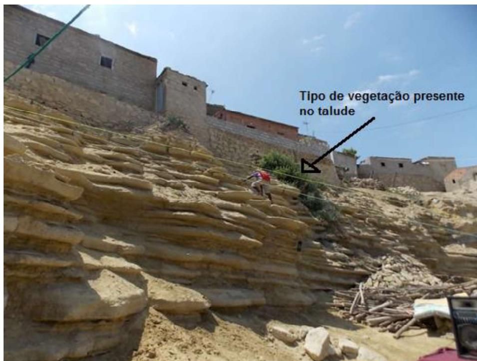
Figura 5.4 - Talude 3 (Bairro do Caputo), onde se observa o tipo de vegetação presente, os movimentos de fluxos, a percolação da água, bem como a dimensão das quedas de blocos.
