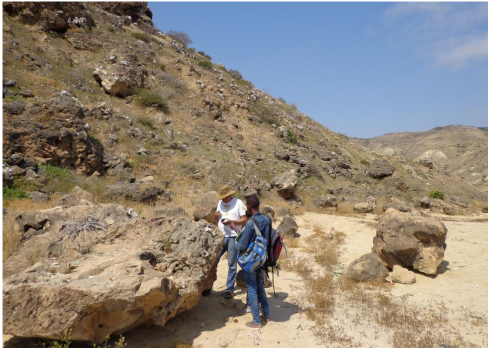
Figura 3.1 – Representação de queda de blocos na 2ª estação da área de trabalho.
