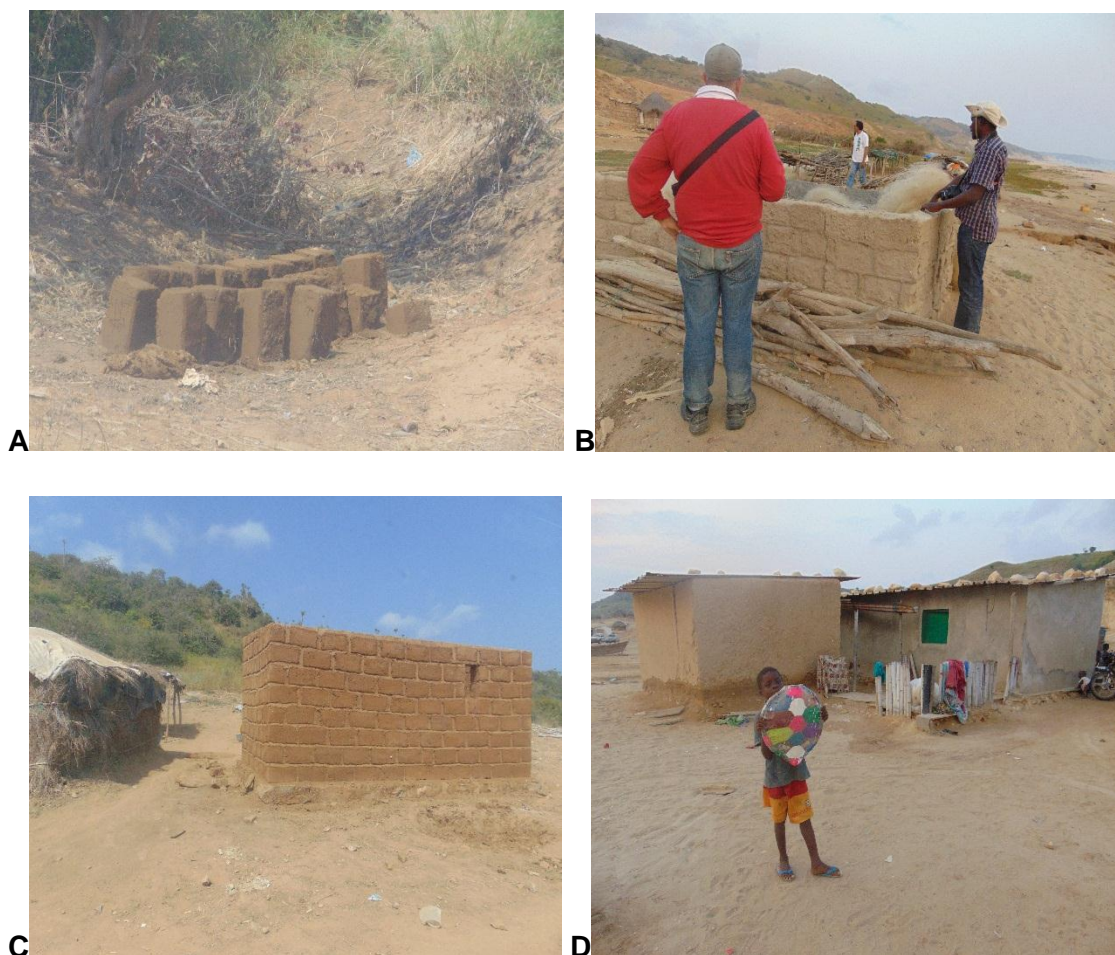
Figura 4.11 A-D – Ilustração do processo de fabrico de adobe e seu acabamento em estruturas e habitações de famílias locais.
