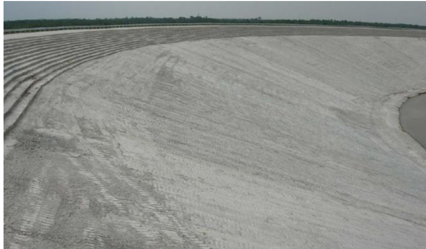
Figura 4 - Exemplo de uma aplicação mista. No topo, proteção em escadaria, e em baixo, uma camada paralela à face do talude (Richards e Hadley, 2006).
