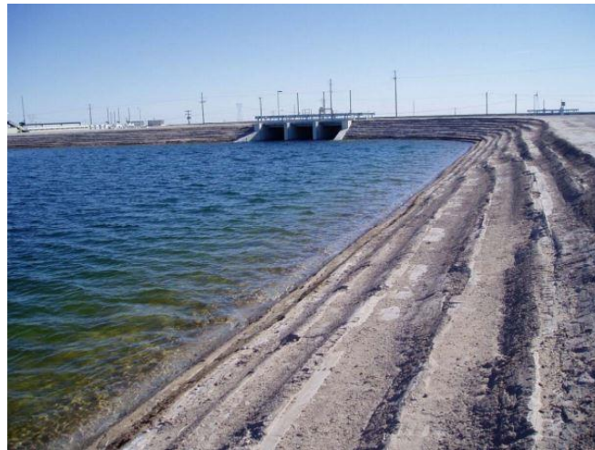
Figura 3 - Exemplo de uma aplicação de proteção em escadaria (stairstep slope protection) (USBR, 2013).
