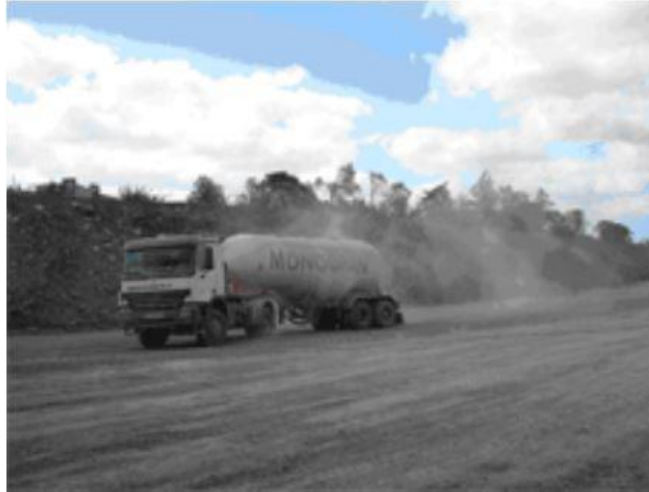
Figura 2 - Pormenor da aplicação de solo-cimento na A16. Fonte: http://www.cimpor.com/artigo.aspx?lang=pt&id_object=1208&name=Solo---cimento-no-IC16 (acesso em 03/12/2020).
