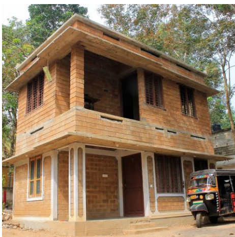
Figura 8 - Casa construída com tijolos de solo-cimento (retirado de: https://veena-constructions.business.site/ , acedido em 23/02/2021).
