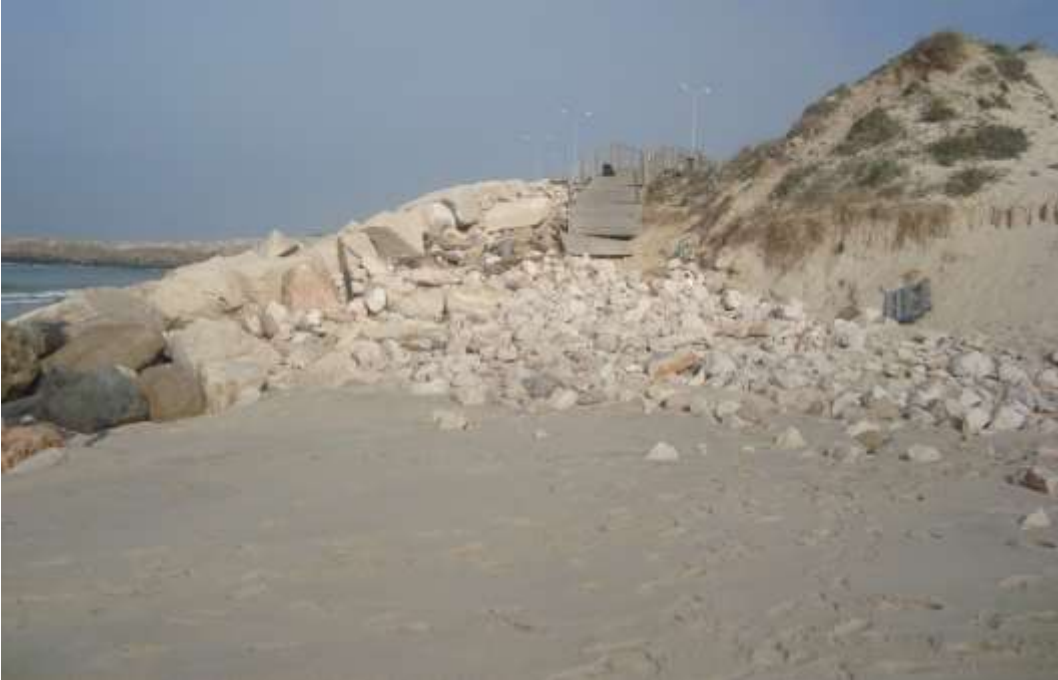
Figura V. 28- Danos decorrentes do avanço do mar a sul do esporão de proteção na praia da Leirosa. Fonte: Wendson Medeiros, novembro/2010.
