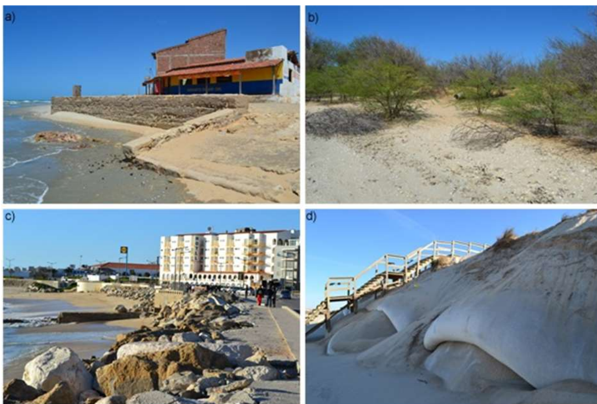
Figura II. 2- Aspectos de avanço do mar nas áreas de estudo: a) construção de muro para conter o avanço das águas do mar em Ponta do Mel, Areia Branca (2013); b) avanço do mar para áreas de caatinga, com destruição de bueiros para escoamento de água pluvial (Morro Pintado, Areia Branca, 2013); c) calçadão destruído e protegido com enrocamento de pedras na praia de Buarcos (Figueira da Foz, 2012); d) avanço do mar com consequências erosivas na praia de Leirosa, expondo geotêxteis protetores do emissário submarino de efluentes industriais (Figueira da Foz, 2012). Fonte: Wendson Medeiros, pesquisa de campo.
