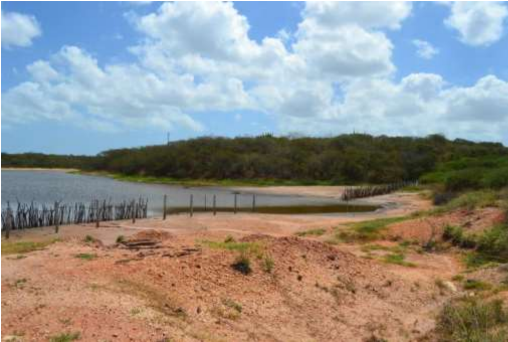
Figura IV.25- Reservatório de água doce sendo utilizado para produção de sal no período seco. O enchimento do reservatório se dá por meio de bombeamento elétrico das águas das salinas situada à jusante do reservatório. Fonte: Wendson Medeiros, agosto/2011.
