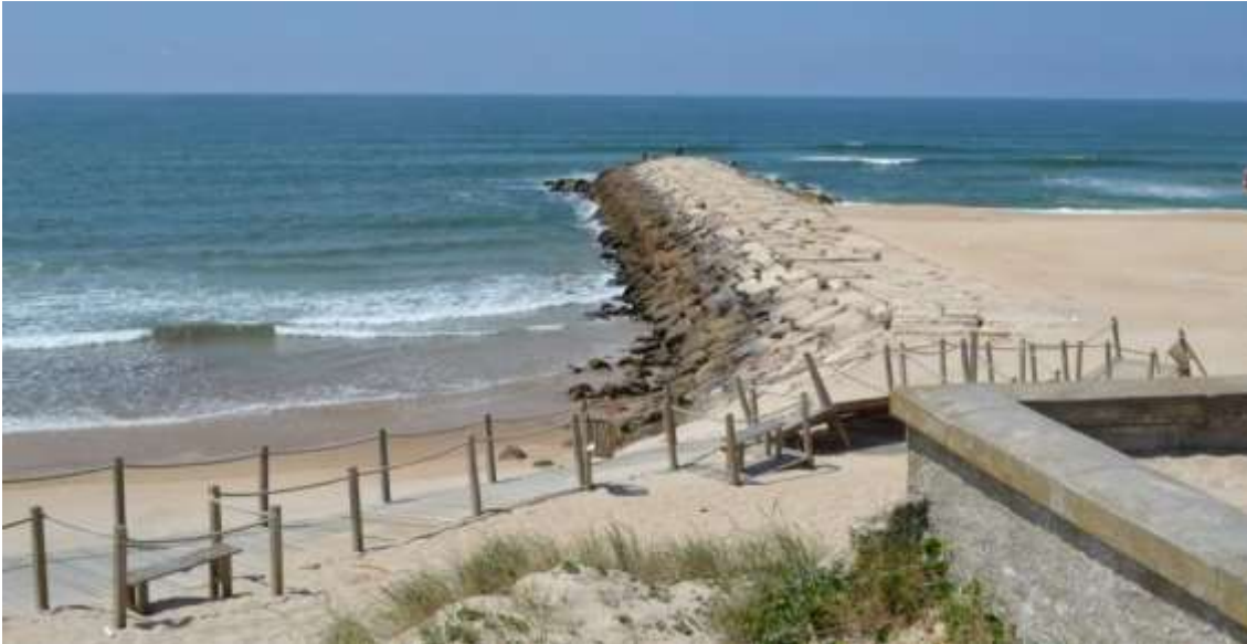
Figura V. 22- Acréscimo de área de praia a norte do esporão de proteção costeira e erosão a sul, na Costa de Lavos. Fonte: Wendson Medeiros, maio/ 2011.
