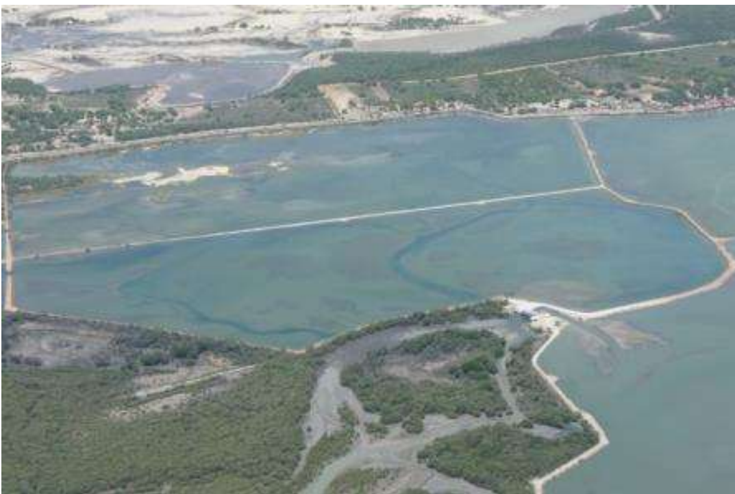
Figura IV 32- Aspectos das salinas em Areia Branca, enfatizando as rupturas e barramentos dos canais naturais. Fonte: Frederico Fonseca/IBAMA-RN (2013).
