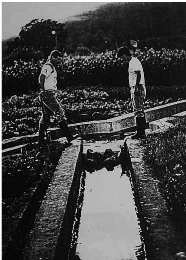
Imagem 09: Controlando a eficácia do Tapume para evitar perdas de água
