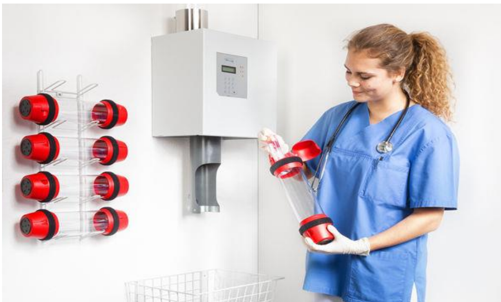
Figura 4: Sistema de transporte pneumático
