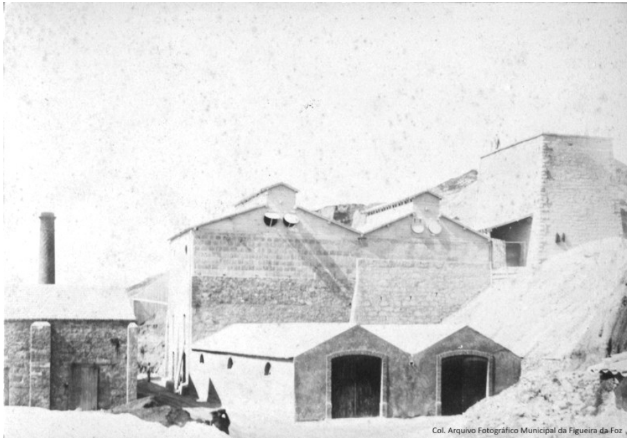
Fig.1.45 Cabo Mondego, fábrica de cal, s.d. [c.a.1880-?] Fotografia da coleção AFMFF.
