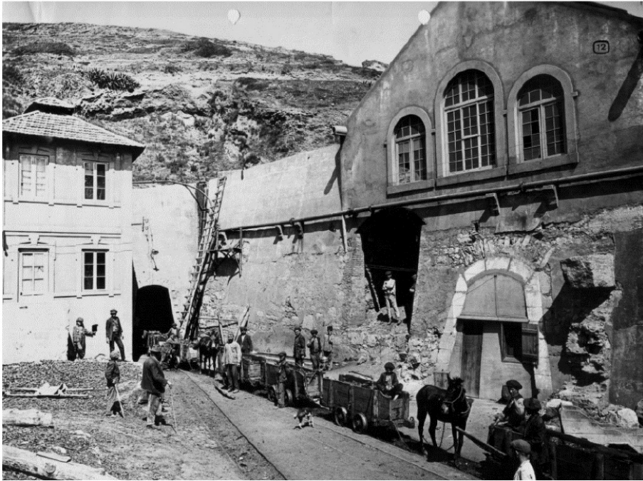
Fig.1.64 Armazém dos compressores., [c.a.1926-19-?] - in - Santos, Manuel Joaquim Moreira dos.1982. Op Cit.
