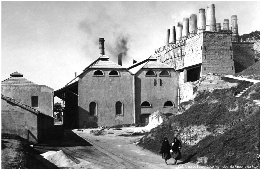
Fig.1.70 Entrada da Galeria Nova Mondego , [c.a.1927-195?] Fotografia da coleção AFMFF.
