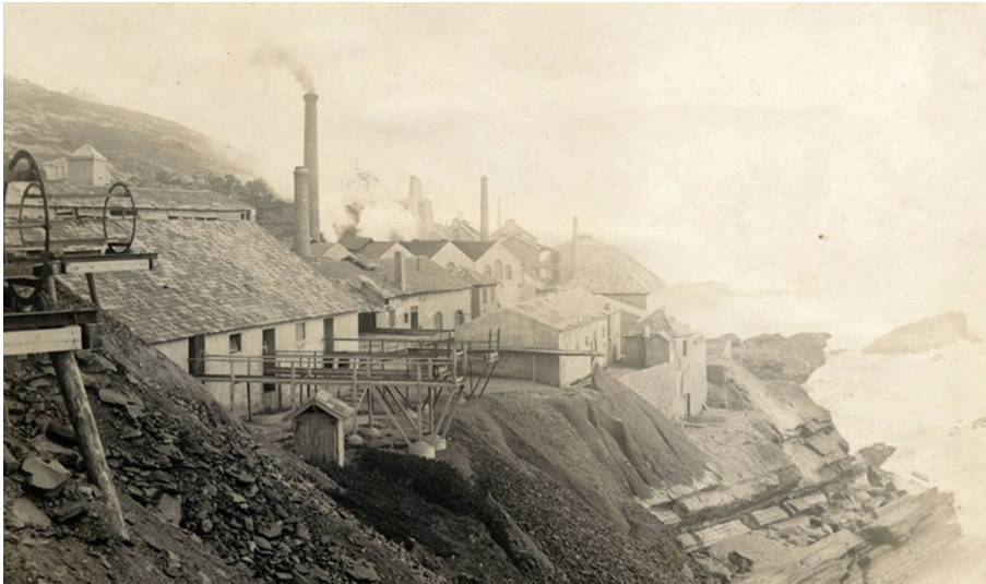
Fig.0.1 Cabo Mondego, indústrias, s.d. [c.a.1900-1920?] Fotografia da coleção AFMFF. (fotografia do Terreiro das Minas velhas e da confrontação do edificado com a praia)
