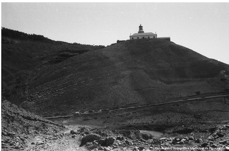
Fig.1.59 Serra , [c.a.1922-19-?] Fotografia da coleção AFMFF. (cota: CH cx50 18 Cx18-253_10-08-1939 Serra NPR02108) (Fotografia do Farol Novo com o local onde foi escavada a pedreira Norte ).
