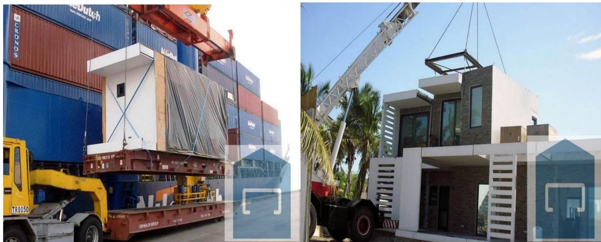
Figura 2.9 – Transporte (esq.) e montagem (dir.) de uma moradia constituída por módulos e estrutura em LSF (Futureng@,2015)
