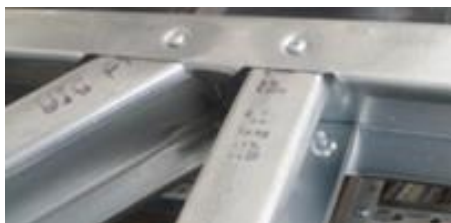
Figura 4.4 – Pormenorização das ligações internas das subestruturas treliçadas
