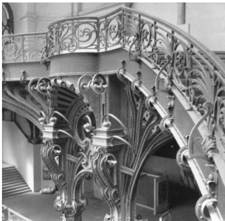
57. Grand Palais , pormenore de uma escadaria; Paris, 1900. Apesar da beleza da escada ser indiscutível, não deixa de ser uma subversão do princípio estrutural: a utilização do ferro passa de funcional a decorativa.
