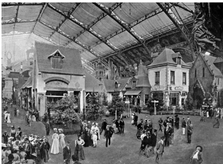
61. Palais des Machines em 1900, exposição de uma aldeia pitoresca. A sensação de leveza da estrutura foi totalmente dissimulada pela multitude de edifícios expostos e pela parte vítrea da cobertura ter sido encoberta por tecidos.
