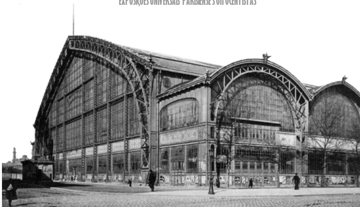
42. Palais de Machines ; vista Sul: Avenue de Suffren / Avenue Motte-Piequet; Paris, 1889.
