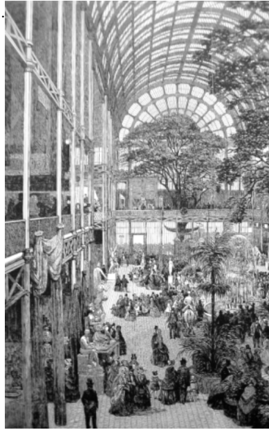
7. Crystal Palace , vista interior do transepto; Londres, 1851.
