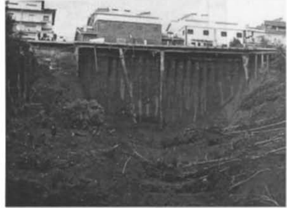
Fig. 11 - Vista da cortina de estacas ancorada após o escorregamento.
