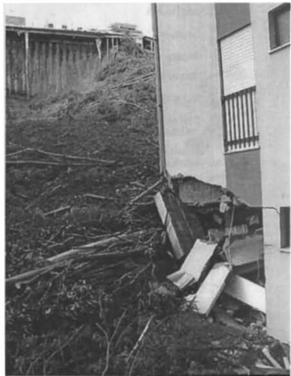
Fig. 12 - Vista do prédio da Elísio de Moura com os três pilares cortados.
