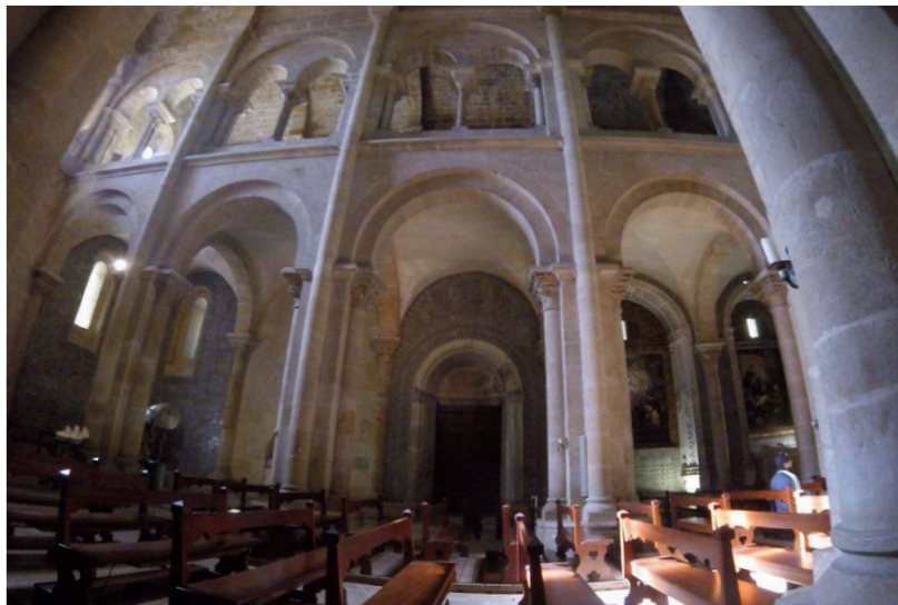
Figura 32 - Alçado Norte interior Sé Velha Coimbra, 1162
