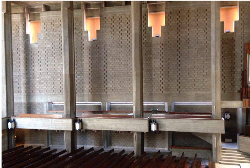
Figura 74 - Alçado interior Poente Igreja Sagrado Coração de Jesus, N.T.Pereira e N.Portas. Lisboa 1970
