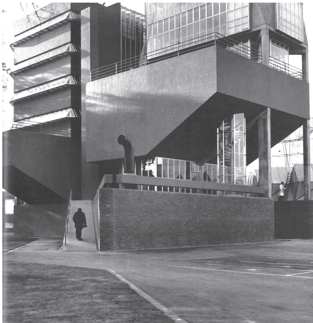
56. Fotografia do acesso à entrada do edifício
