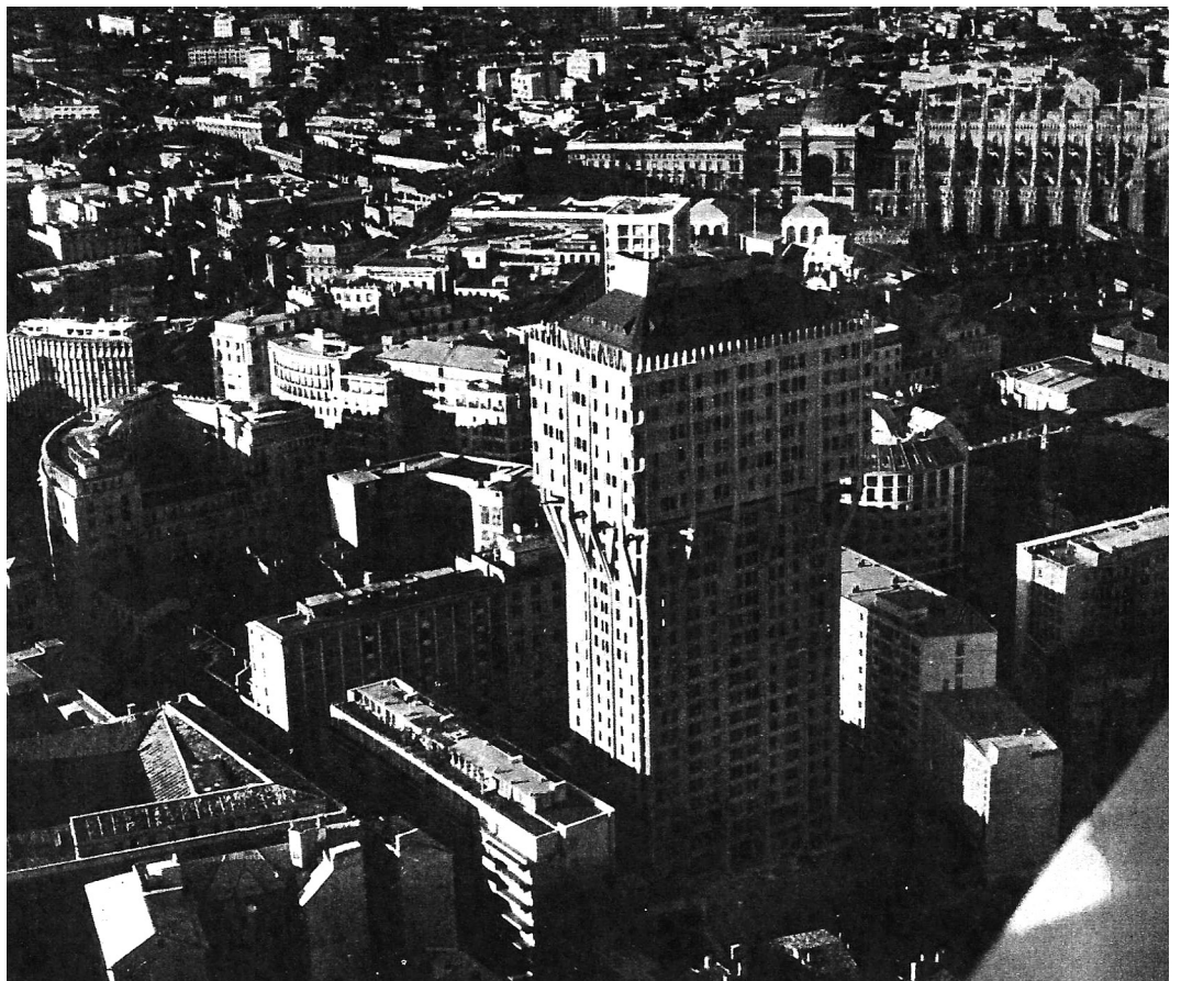
31. Vista aérea de Milão. Posicionamento da Torre Velasca face à sua envolvente
