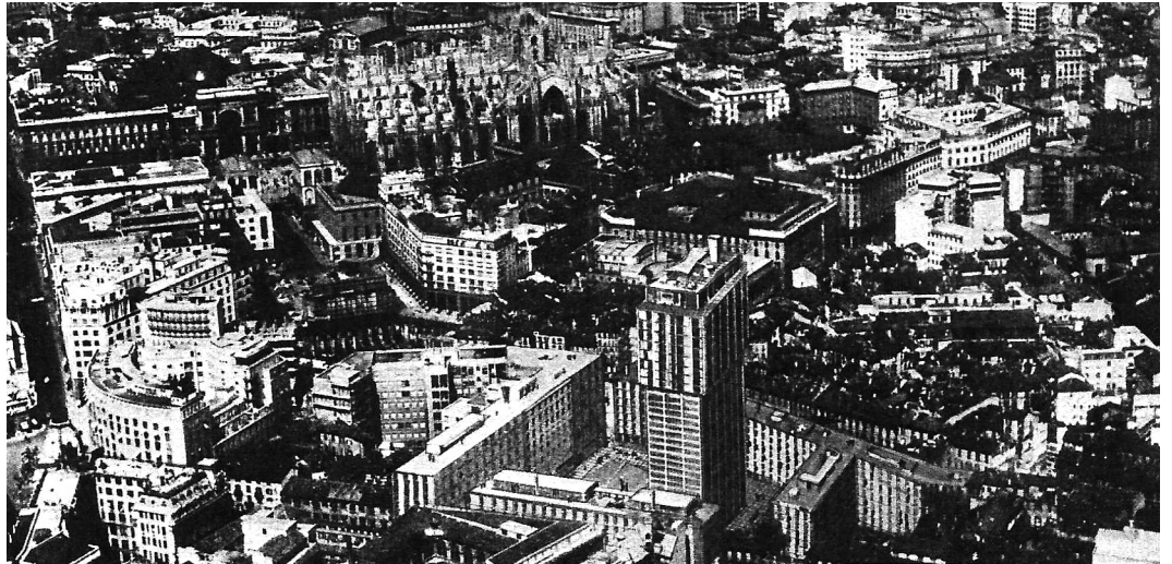
30. Vista aérea de Milão. Posicionamento da Torre Velasca face à sua envolvente
