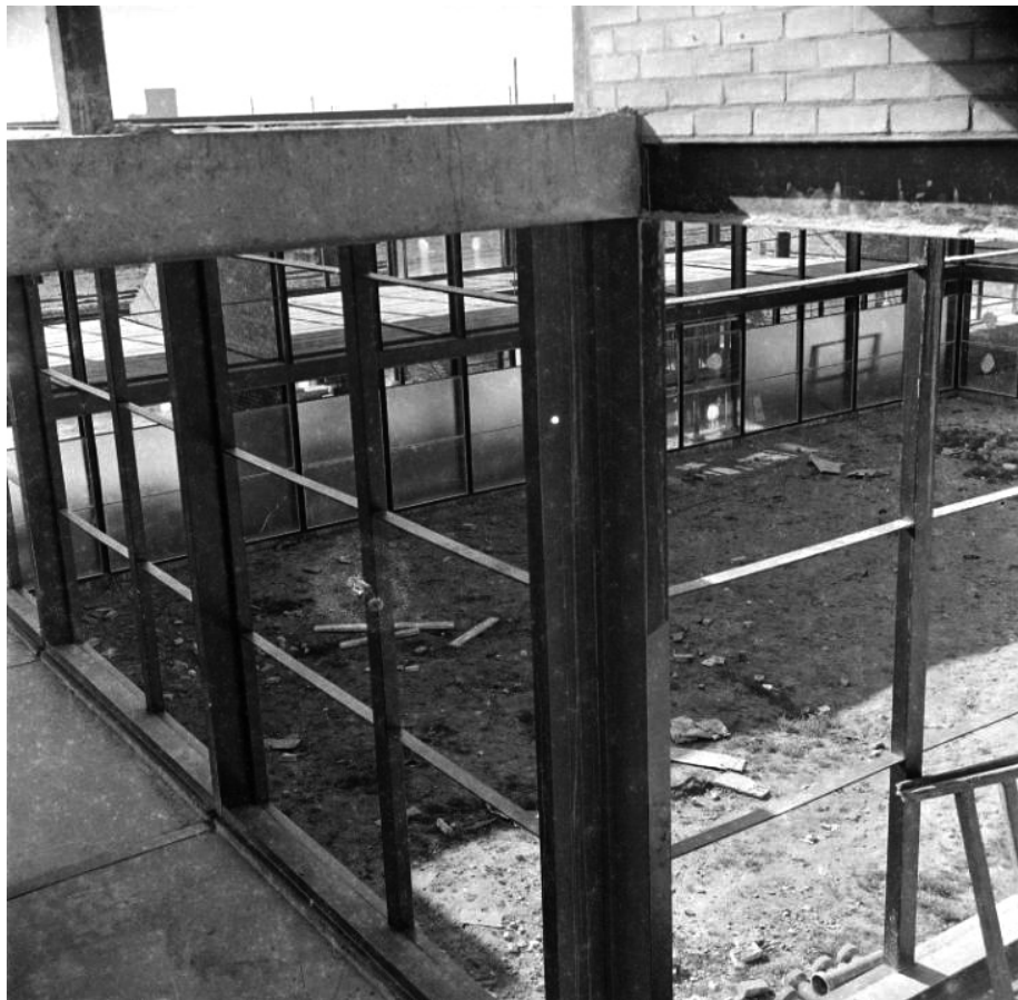
42. Fotografia do encontro do vigamento metálico com a caixilharia
