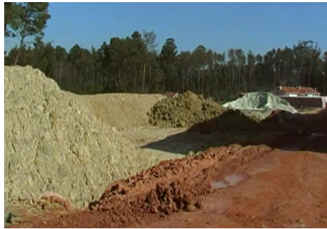
(a) Parque das argilas
