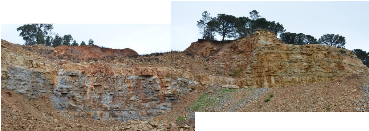
Figura 6.5.4.2. Vista geral do afloramento da Pedreira da Boiça (Portunhos, Ançã), observando-se as frentes de exploração atuais com estratos de calcário, fracamente basculados para sul e, no topo, restos de uma cobertura gresoargilosa associada ao carso superficial e, em primeiro plano, diversas escombreyras.
