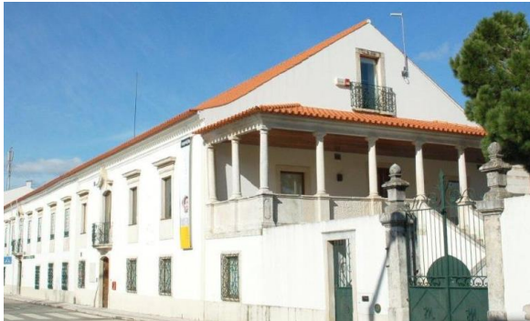
Figura 7.5.1.1. Vista geral da entrada e da fachada exterior do edifício.
