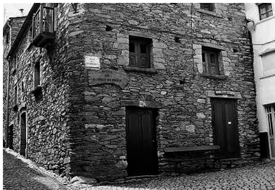
Figura 7.5.8.1. Vista geral da entrada e fachada exterior do edifício.
