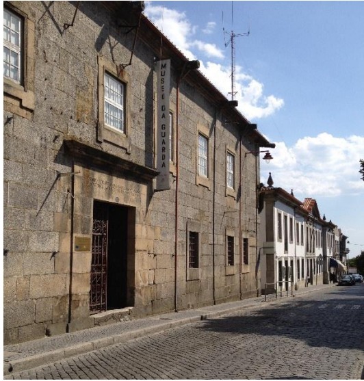
Figura 7.5.4.1. Vista da entrada e fachada exterior do edifício.
