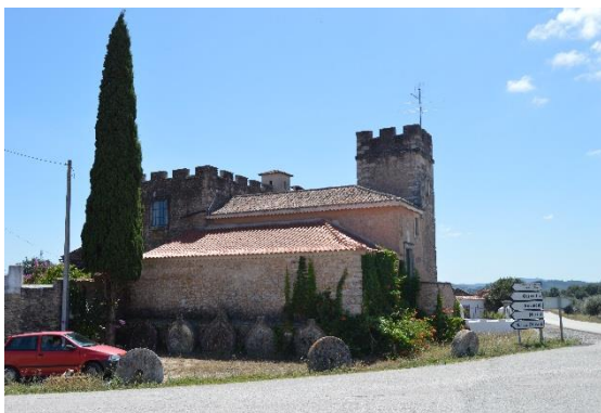
Figura 7.5.12.1. Vista geral do exterior do edifício. Vista da quinta.
