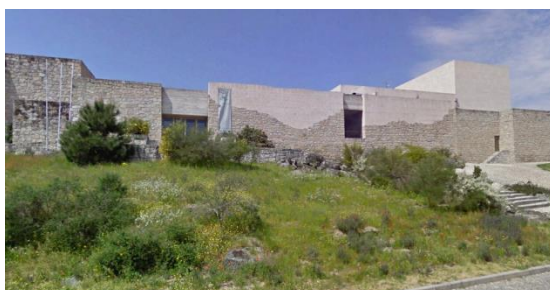
Figura 7.5.3.1. Vista geral da entrada e da fachada exterior do edifício.
