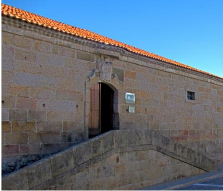
Figura 7.5.9.1. Vista geral da entrada e fachada exterior do edifício.
