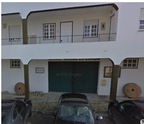
Figura 7.5.16.1. Vista da entrada e fachada exterior do edifício Sede do Museu do Campo.
