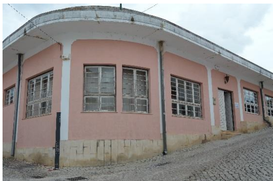
Figura 7.5.7.1. Vista geral da entrada e fachada exterior do edifício.
