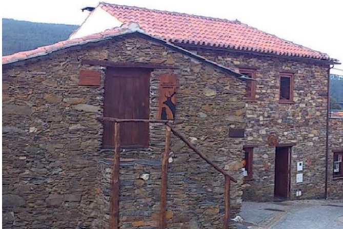
Figura 7.5.10.1. Vista da entrada e fachada exterior do edifício.
