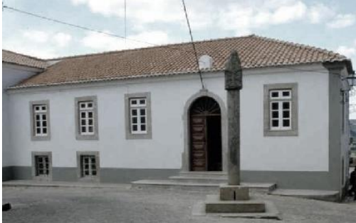
Figura 7.5.5.1. Panorâmica da entrada e fachada exterior do edifício.
