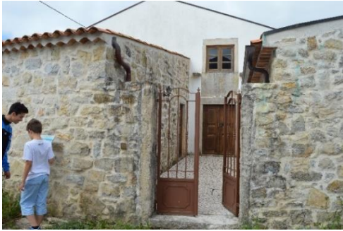
Figura 7.5.14.1. Vista da entrada e fachada exterior do edifício.
