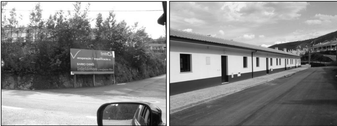
Figura 4.32 - Cabeço do Pião entrada para o bairro Chinês. À direita apartamentos para fins turísticos, recuperados a partir das antigas residências mineiras intervenção efetuada pelo município do Fundão em 2006. Até à data (2014) estão sem qualquer tipo de uso
