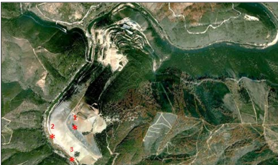
Figura 2.28- Locais onde foram retiradas amostras de solo. (1) Efetuada ao longo da barragem de lamas e na área atrás da barragem; (2) amostragem realizada no fundo da parede da escombreira que contacta diretamente com o rio Zêzere e (3) margem do Zêzere (S. ANTUNES, 2010).
