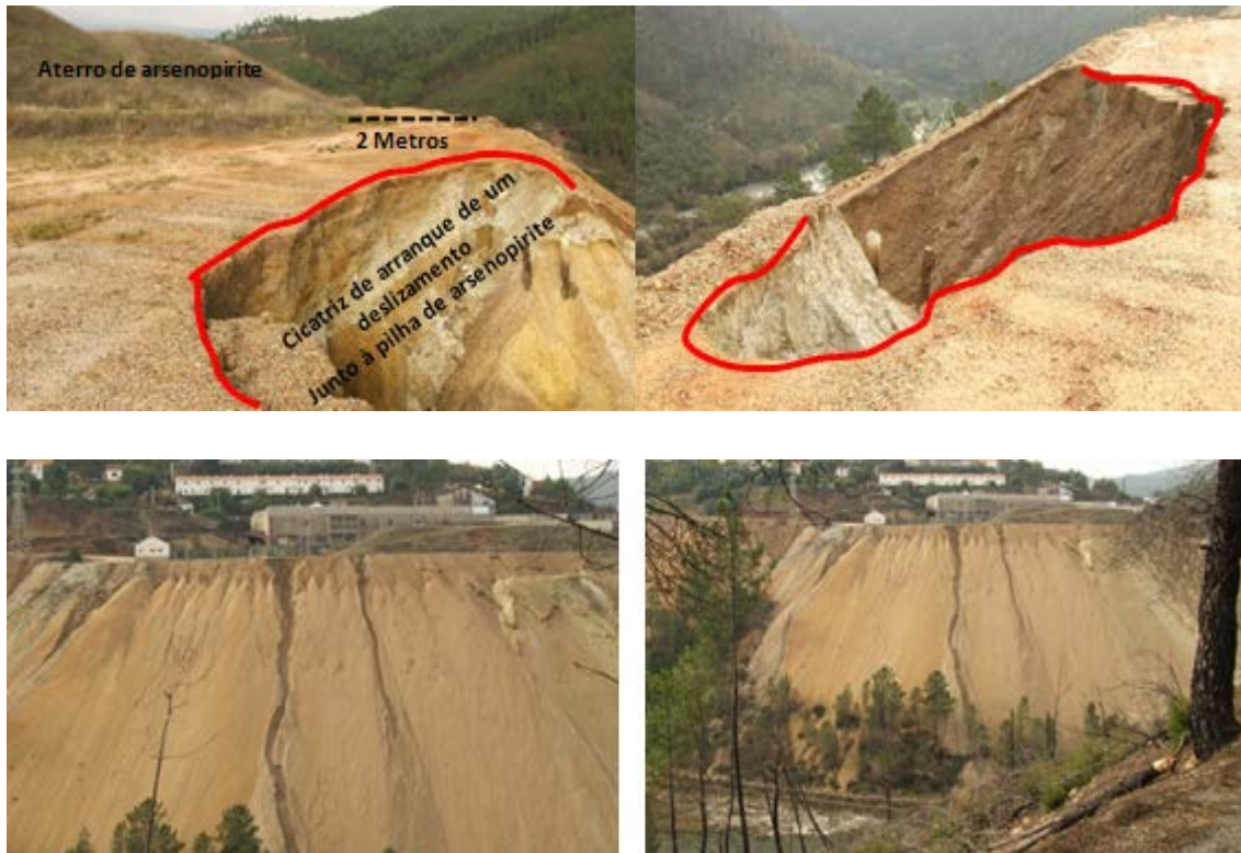
Figura 3.9 - Sequenciais - Efeitos da precipitação ocorrida em outubro de 2006, junto da pilha de arsenopirite, um deslizamento cortou o caminho que circunda a pilha de arsenopirite, fez movimentar materiais pouco consolidados da escombreira abrindo uma enorme ravina. Imagem da esqª sentido E.Se-W.Nw; imagem da dtª sentido W.Nw-E.Se. Em baixo fotos tiradas da margem dtª do rio Zêzere a cerca de 400 metros da escombreira, vê-se com nitidez a ravina identificada na foto acima.
