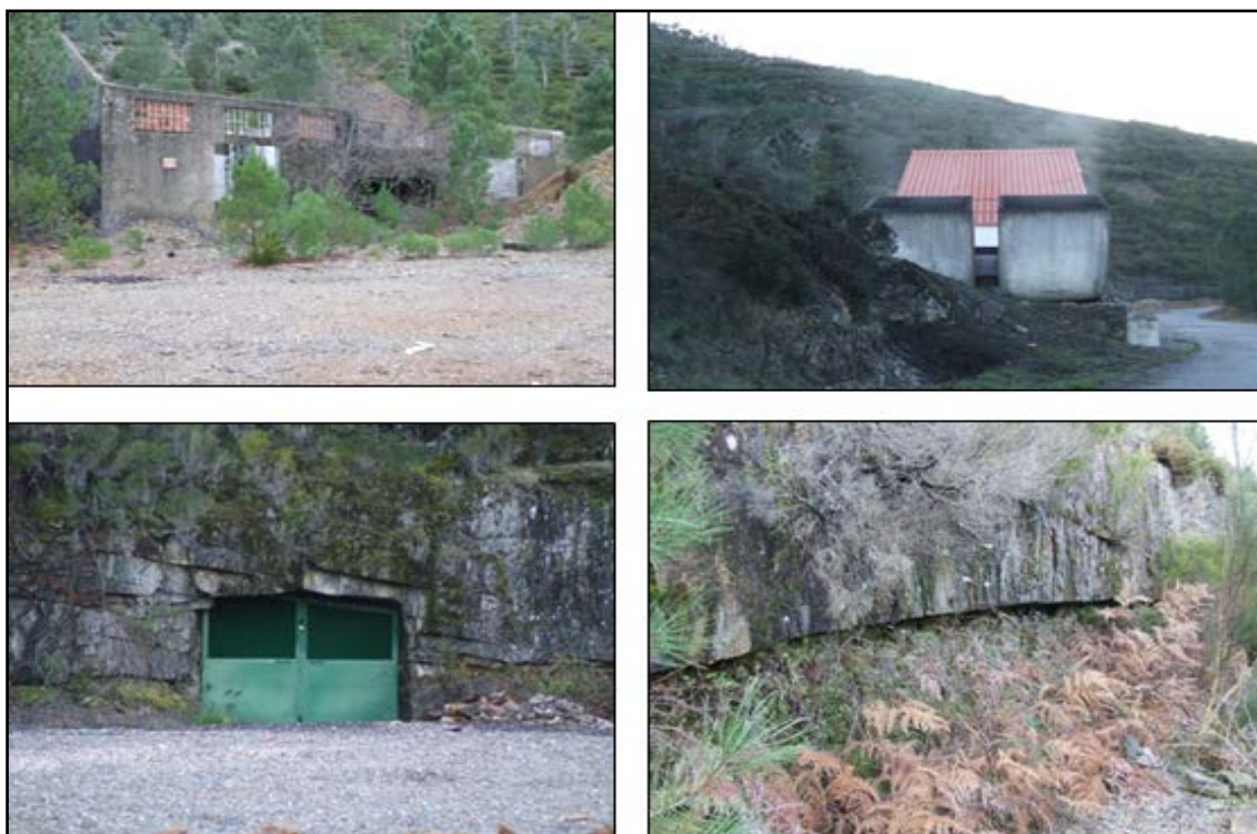
Figura 7.20 - Imagens das antigas instalações da mina do Vale da Ermida e respirador da mina ainda hoje ao serviço. Em baixo imagens da entrada da mina da Ermida e a falha que lhe está associada.
