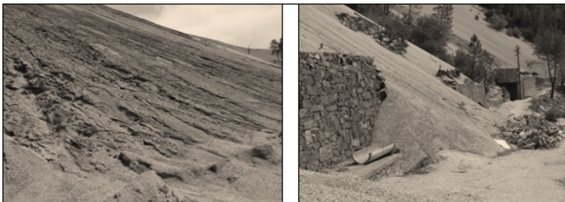
Figura 4.18- Instalação de ravinamentos e destruição da carapaça oxidada, e destruição de muro de suporte da escombrela que suporta a barragem de lamas no Cabeço do Pião (fotos do autor, Março de 2011)
