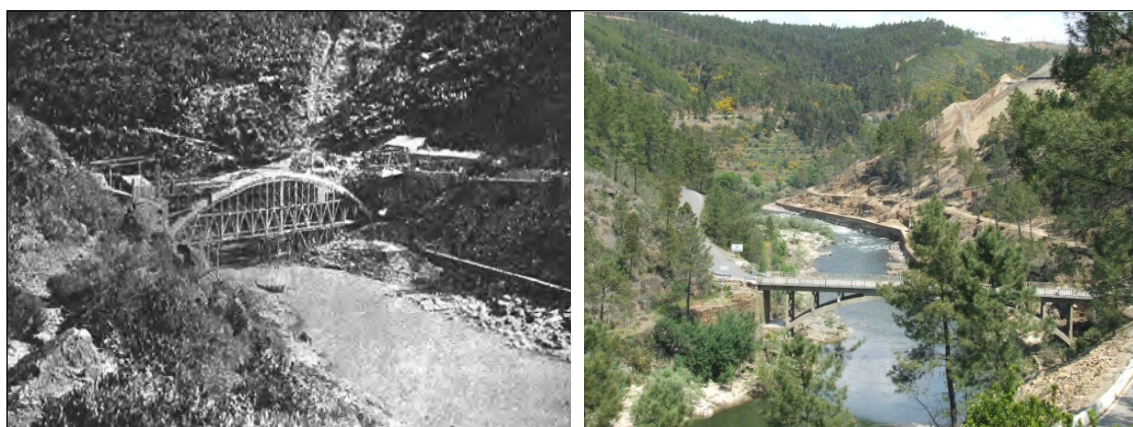
Figuras 6.2 e 6.3 - Início da obra da Ponte sobre o rio Zêzere em 1928 e mandada construir pela BTWP, a 6.3 retrata a ponte nos dias atuais (foto do autor, 2011)
