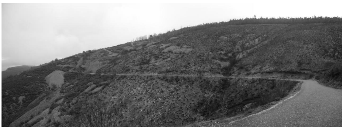
Figura 4.33 - Pequenas escombreliras resultantes da exploração no período áureo das Minas, no Kilo e na Pilha. Dessimam-se um pouco para sul em direção ao Zézere (Alvoroso) e sudoeste da Mina da Panasqueira em direção ao Vale da Ermida, criando muitos obstáculos ao crescimento da vegetação autóctone, agravado pelos constantes incêndios de verão.
