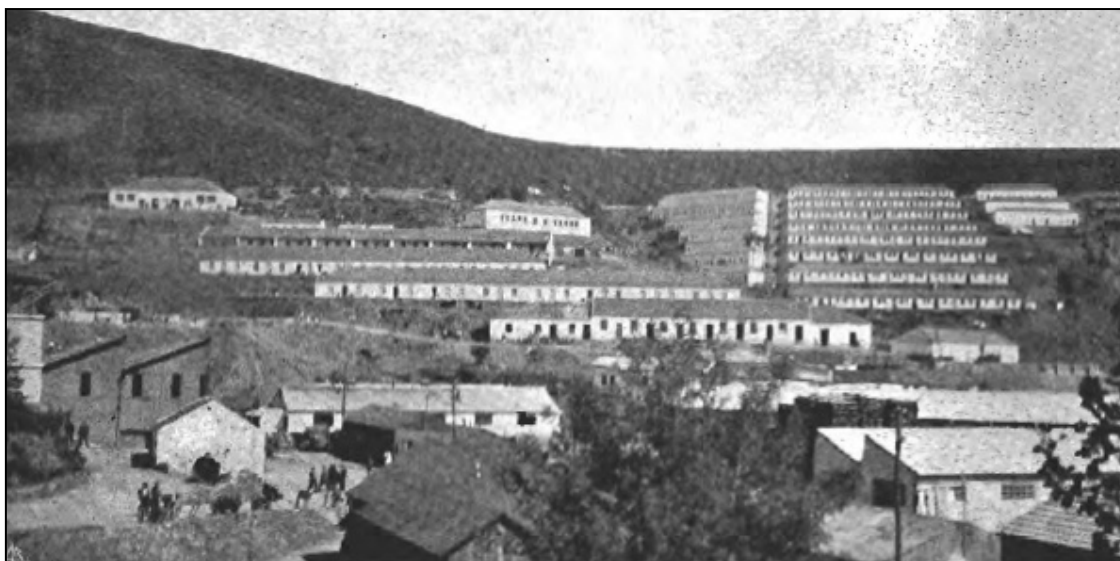
Figura 7.23 - Fase final da construção do bairro mineiro na Barroca Grande (M. LEAL, 1945)
