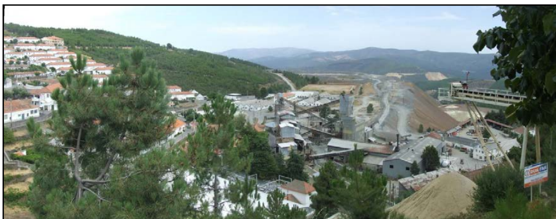
Figura 7.22 - Imagem de enquadramento da Barroca Grande, vendo-se a lavaria e parte das infraestruturas da SBTWP
