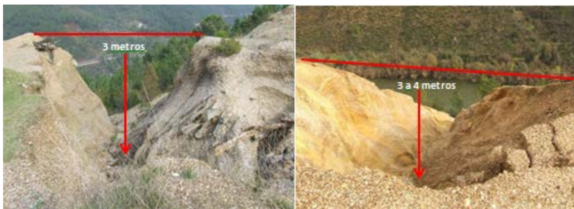
Figura 4.24 – Instalação de ravinas na escombreira da Panasqueira e na escombreira do Cabeço do Pião (fotos do autor)
