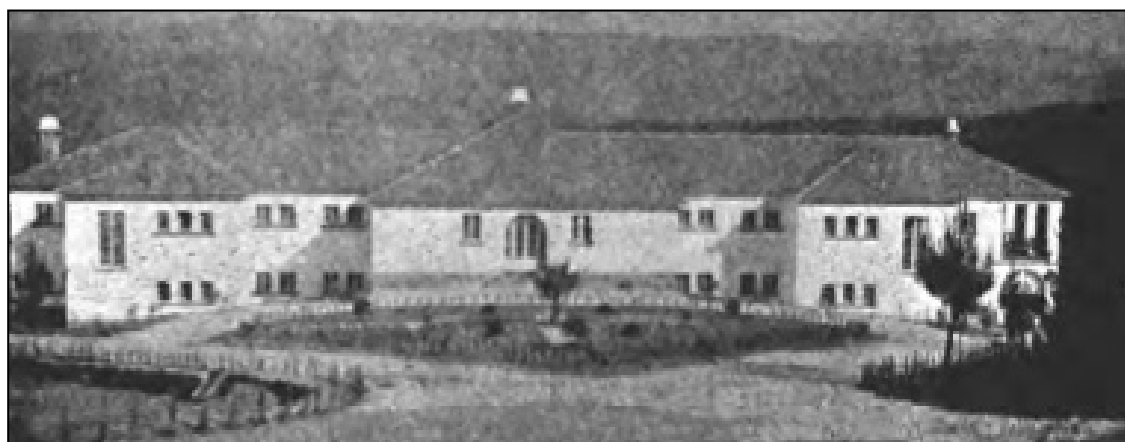
Figura 7.24 - Aspeto geral do Hospital da Barroca Grande após a sua conclusão (M. LEAL, 1945). Este edifício é hoje pertença da Santa Casa de Misericórdia do Fundão e funciona como lar da terceira idade.
