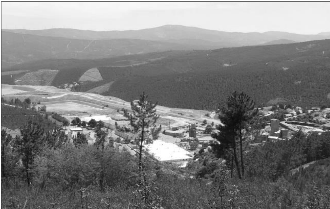
Figura 4.4 e 4.4A - Início das operações mineiras na Barroca Grande, início dos anos 40 do século XX. Mais recentemente 2011, o vale da ribeira do Bodelhão já não se identifica está totalmente coberto pela escumbreira.
