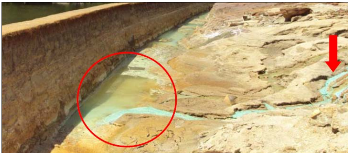
Figura 4.26 - Vista do terraço inferior na parte norte da base da escombreira. O círculo e a seta a vermelho destacam as drenagens ácidas e a sua acumulação, in SILVIA ANTUNES, 2010.
