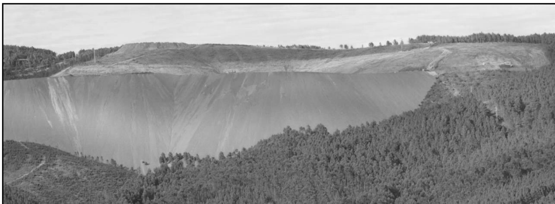
Figura 5.5 A, B e C – Na 5.5 A - Início da expansão da escombreira para construção da nova barragem de lamas (2005). 5.5B Imagem - conclusão dos trabalhos de expansão da escombreira e conclusão da nova barragem de lamas (2013) (imagens Google Earth). 5.5C - Vista geral a partir da Aldeia de S. Francisco de Assis da nova barragem de lamas (foto do autor Abril de 2014)
