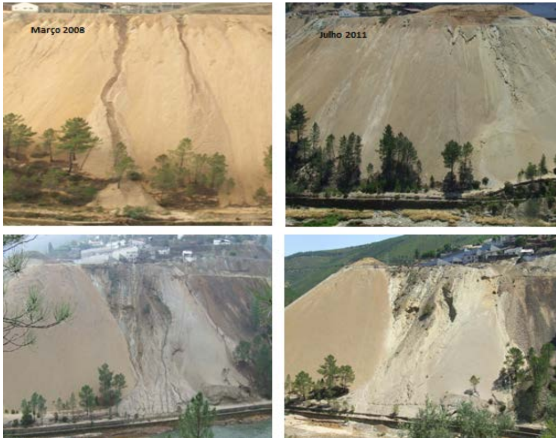
Figura 4.6 - Na escombreira do Cabeço do Pião, em dois locais distintos podem ver-se profundas ravinas provocadas pela ação da erosão hídrica mais visível durante o semestre com mais precipitação
