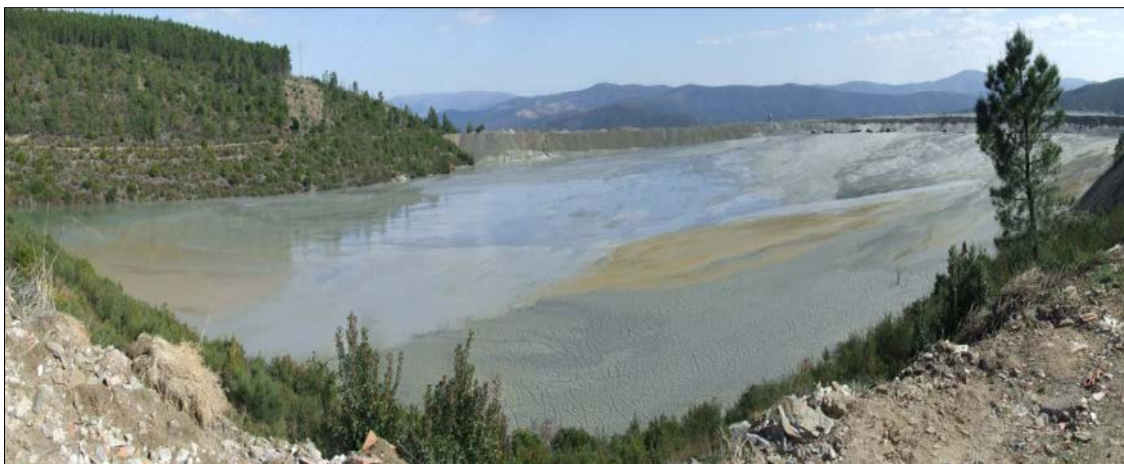
Figura 4.9 e 4.9A- Acima material depositado na escombreira. Verifica-se o carácter grosseiro do estéril em contra ponto com os resíduos resultantes do processo de tratamento do minério e que é depositado na barragem de lamas (fotos do autor 12.3.2012)
