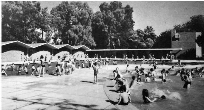
140 - 142. Edifício da Câmara de Hilversum , W. M. Dudok, 1923/31 143. Casa de Chá e Miradouro de Montes Claros no Parque de Monsanto , Keil do Amaral, Lisboa, 1939-40 144. Piscina Infantil do Campo Grande , Keil do Amaral, Lisboa, 1960-63
