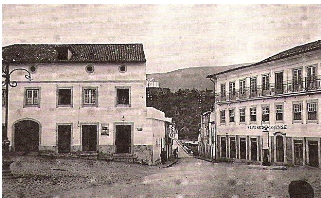
17| Praça da República depois de alargada a Rua da Ponte. Edifício da Havaneza Goiense à direita.
