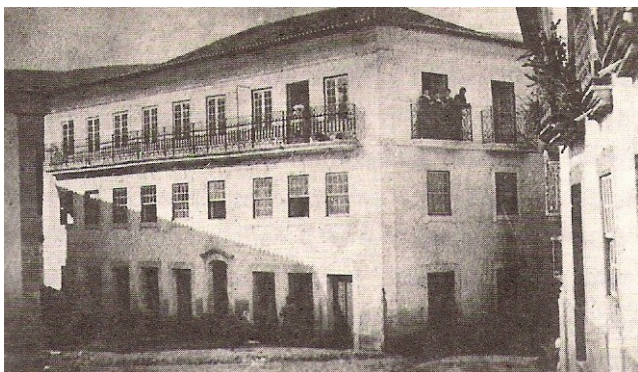
16| Praça da República antes de se alargar a Rua da Ponte.
