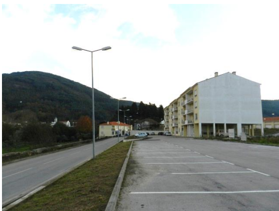
37| Avenida Dr.Padre António Dinis. Espaço pré- edificado para o qual estavam propostos dois edifícios de habitação colectiva.
