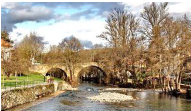
54 | Ponte de três arcos.
