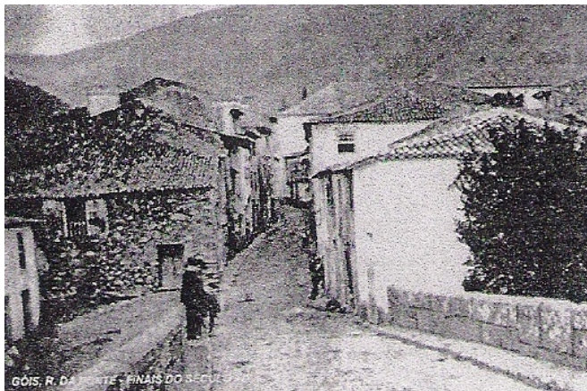
18| Rua da Ponte antes de ser alargada.
