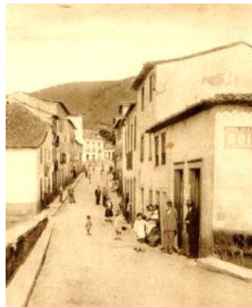
19| Rua da Ponte depois de ser alargada.
