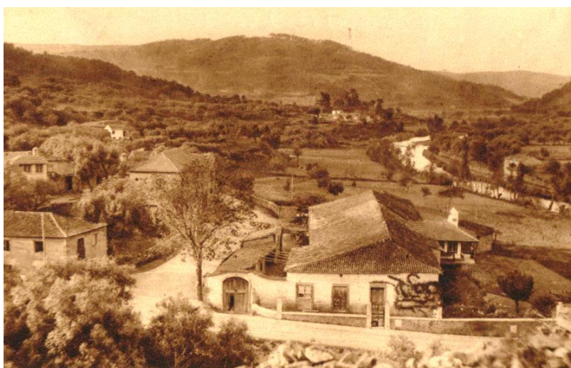
14 | Solar dos Sanches, localizado na margem esquerda do Rio Ceira.
