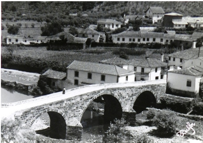
9|Ponte Manuelina sobre o Rio Ceira. O vazio urbano visível nesta imagem, atrás da ponte, corresponde à localização dos Paços Novos .
