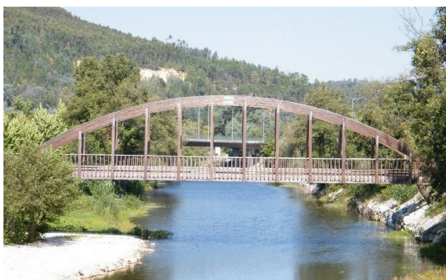
53 | Ponte pedonal de madeira.
