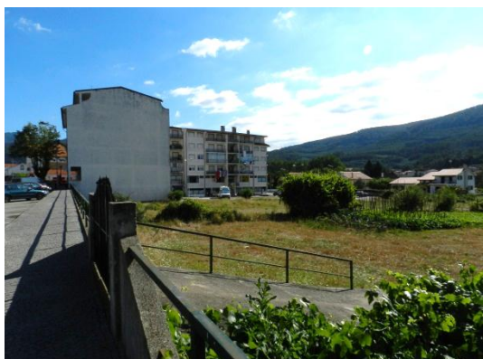
41| Área de Intervenção. Vista da Rua Comandante Henrique Bebiano Neves.
