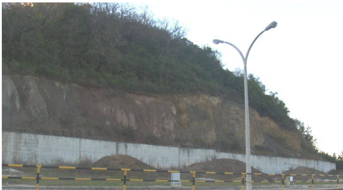
Fig. 3-16 – Talude de Belo Horizonte.
