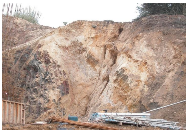
Fig. 6-40 – Escavação no limite do depósito do Pliocénico no campus 2 do IPL.
