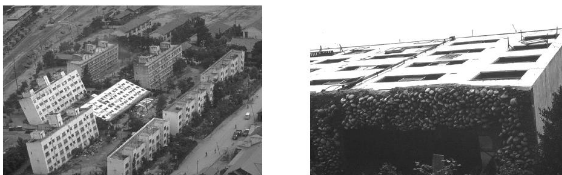
Fig. 4-7 - Edifícios Kawagishi-cho, em Niigata no Japão: (esquerda) derrube devido à falta da capacidade de suporte resultante da liquefação dos solos de fundação; (direita) pormenor da zona de rotura da fundação superficial (Kramer e Elgamal, 2001).
