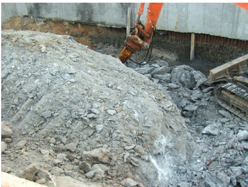
Fig. 3-3 – Massa de gesso no seio da Formação de Dagorda, na rua Machado dos Santos em Leiria.
