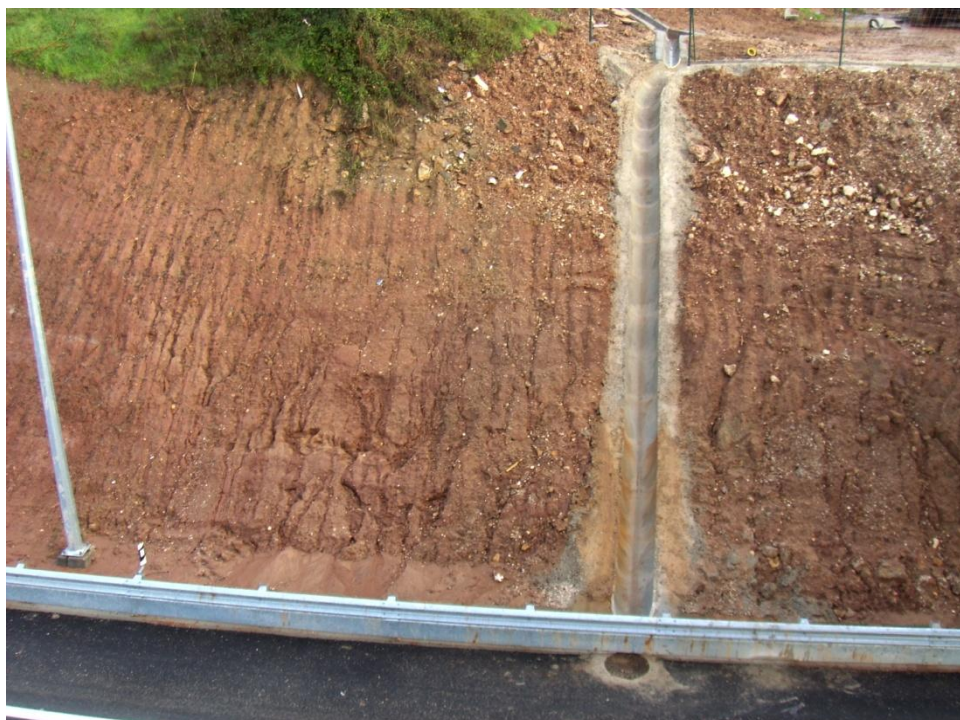
Fig. 9-6 – Talude escavado na Formação de Dagorda.
