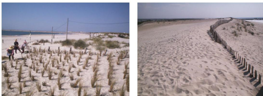
Figura 30 - Plantação de vegetação em dunas e colocação de paliçadas, como formas de retenção de areias (Coelho, 2005).
