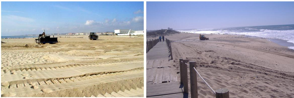
Figura 28 – Processo de reperfilamento da praia em Espinho (Junho de 2008) e da Granja (2008).
