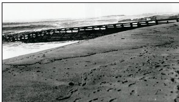
Figura 58 - Esporão experimental em madeira e pedra construído em 1912 (Silva, 1997).
