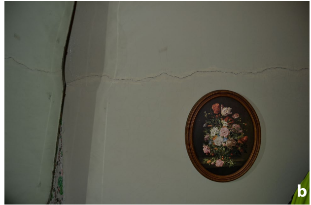
Figura 4. Exemplos de acréscimo de pisos: a) utilização de materiais distintos; b) fissuração horizontal na interface entre o corpo pré-existente e o novo.
