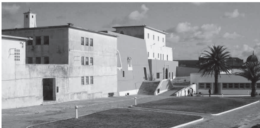
Fig. 10 – Fotografia do complexo depois da intervenção, parlatório visível à direita, Prisão. In Romão, José Carlos (2014). Disponível em http://caldeiradapenicheira.blogspot.pt
