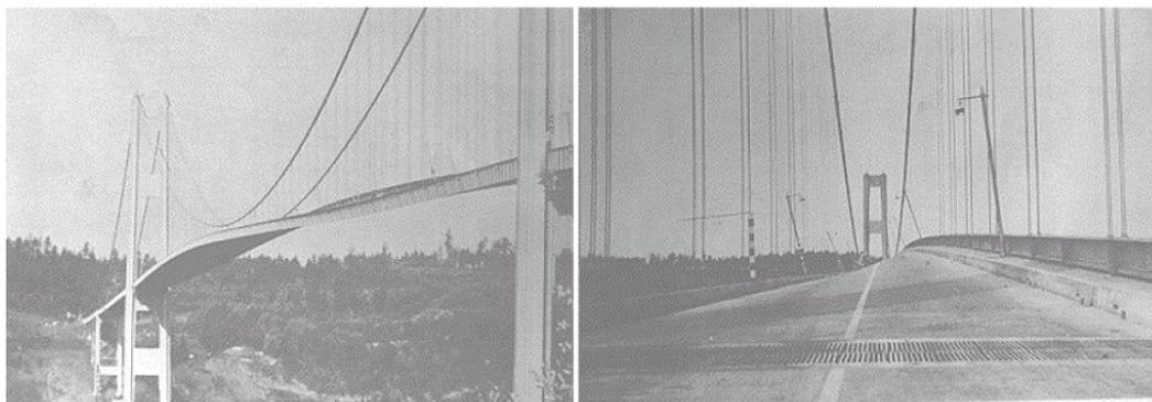
Figura 11 - Deslocamentos rotacionais na ponte de Tacoma Narrows
