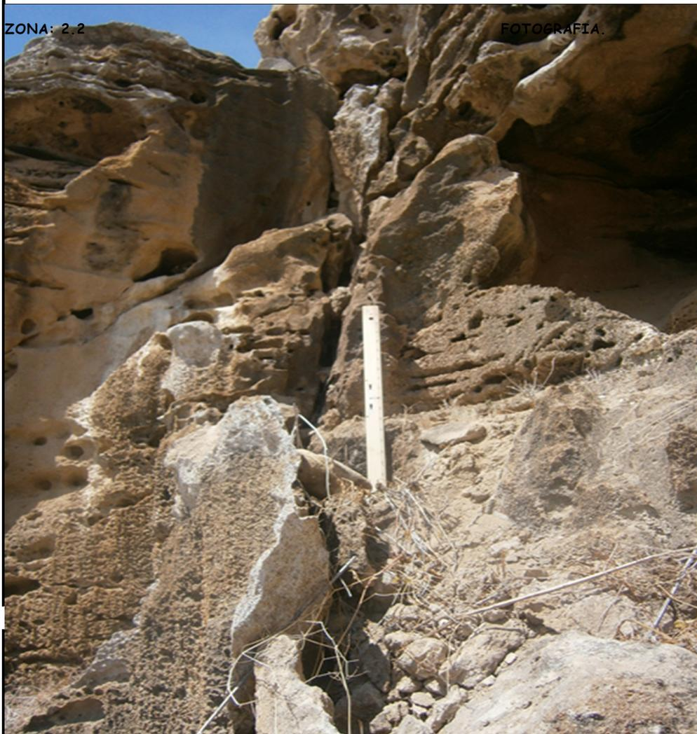
**OBSERVAÇÕES:** O trecho é caracterizado por um talude natural escarpado, com 60° e 54 metros de altura. É composto por arenitos e calcários. Encontram-se pouco alterados, observando-se falésias que em certas ocasiões são influenciadas pela pequena vegetação que aí se encontra.
