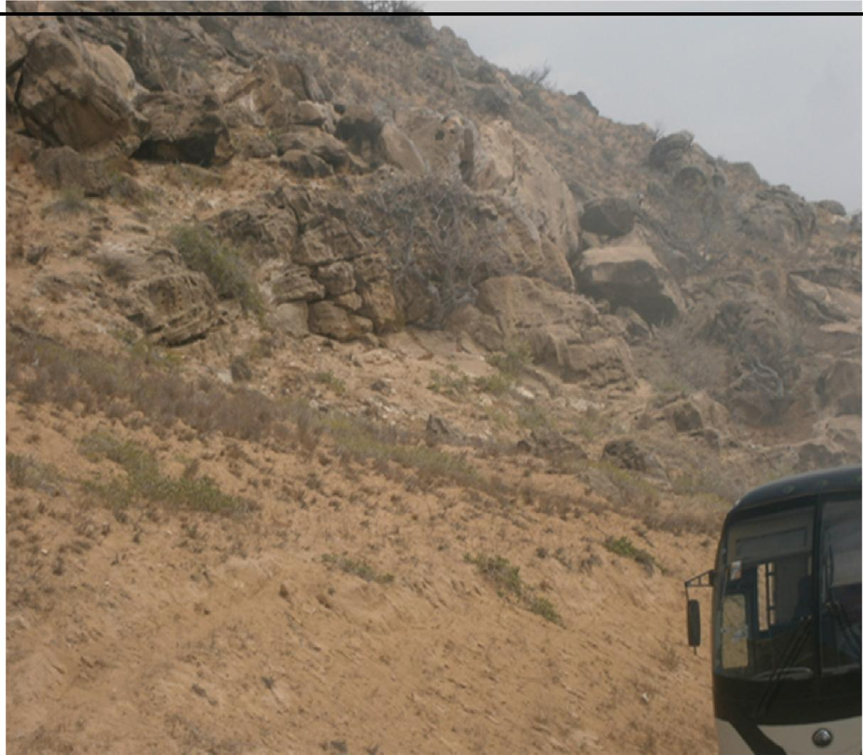
**OBSERVAÇÕES:** A estrada que liga a sede do município da Baía Farta a Baía da Macaca estende-se relativamente adjacente a um talude natural, subvertical de 71 metros de altura e um pendor de 68°. Litologicamente o talude é formado por calcários e por arenitos. As camadas rochosas encontram-se fracturadas. A fracturação rochosa que se verifica nesta zona permite o estabelecimento de situações de instabilidade, que no caso vai potenciar a queda de blocos.
